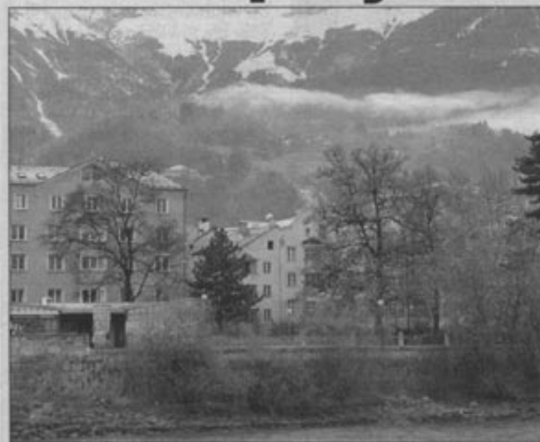
Hochwasserschutz-Projekt ab „Wiesele“ ist durch neue Bahn beeinträchtigt!
